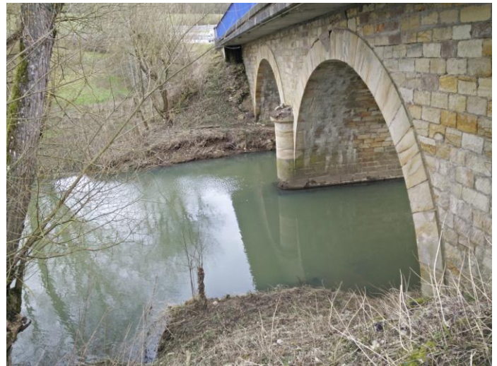
Vue depuis l'aval
