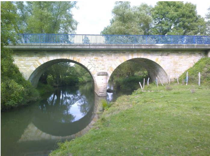
Vue depuis l'amont
